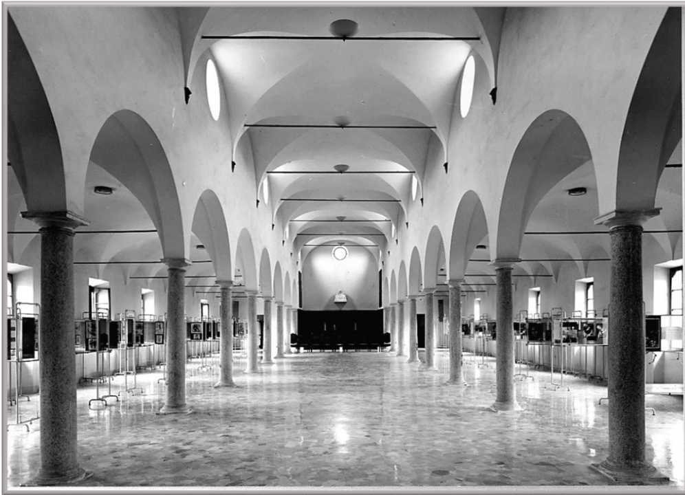
Fig. 2E-2. ARCHIVIO STORICO FOTOGRAFICO DEL MUSEO. Monastery library after reconstruction. 254
