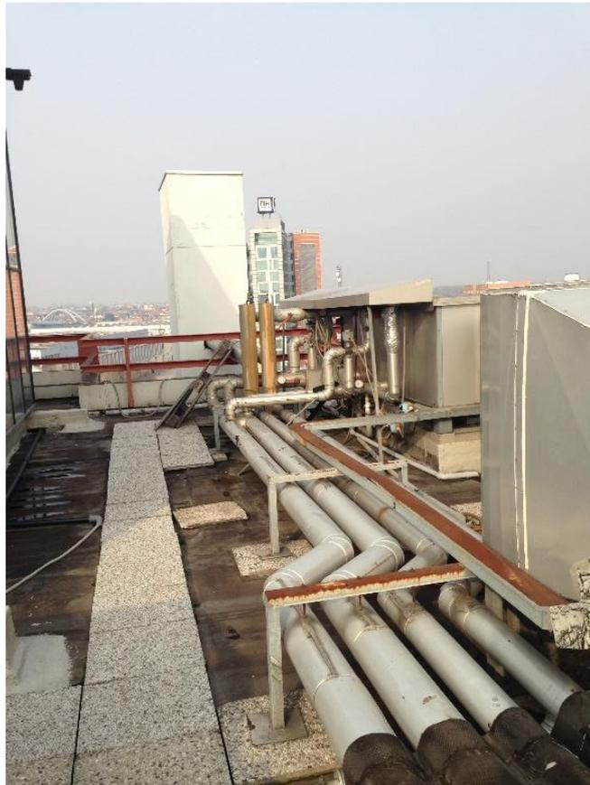
*Figura 49 La Cta dell'aria primaria che serve il sesto piano CRIBI della Didattica Est. Si possono vedere i tubi del caldo e del freddo che alimentano le batterie*
