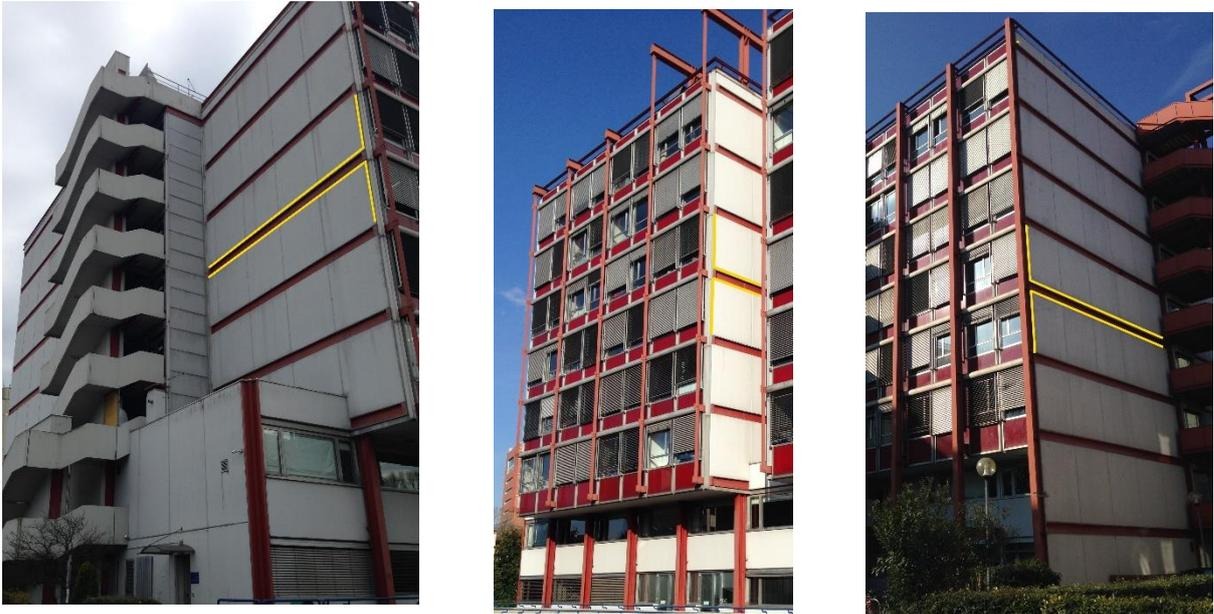
Figura 38 In giallo, il Ponte termico analizzato
