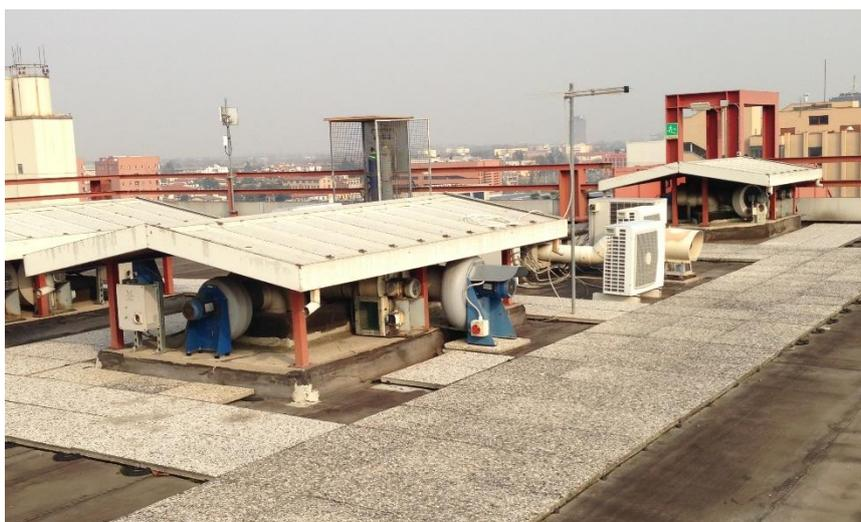
*Figura 57 Ventilatori di espulsione posto a monte di ogni cappa dell'edificio sul piano copertura*
