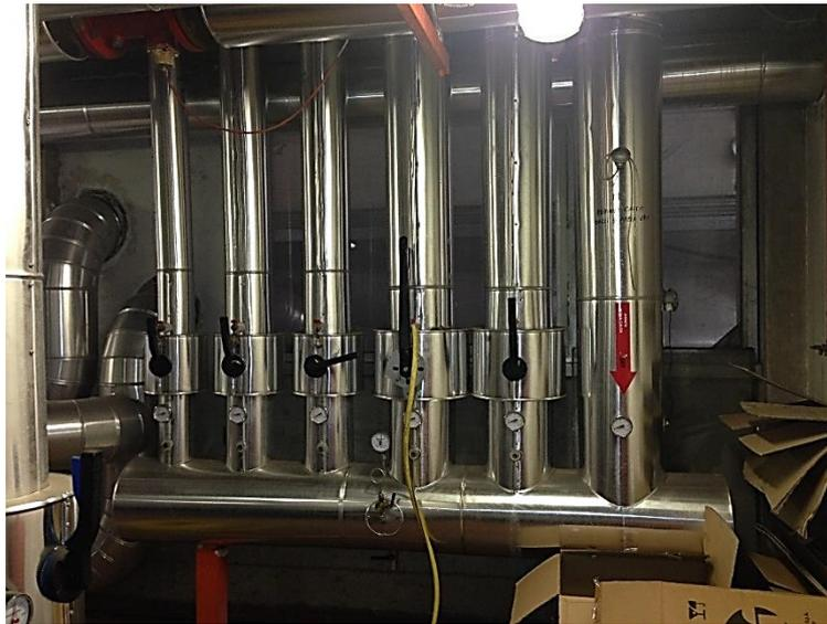
*Figura 62 Collettore di mandata. Sulla destra si nota il condotto proveniente direttamente dagli scambiatori, le restanti, con senso di flusso opposto, sono le prime 5 utenze descritte nell'elenco.*
