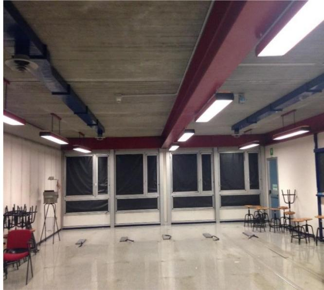
Figura 31 Vista di quattro finestre all'interno di un laboratorio didattico in zona scientifica Est: si nota come la parte superiore delle stesse confini con la trave mentre la parte inferiore è ricoperta da una pellicola isolante
