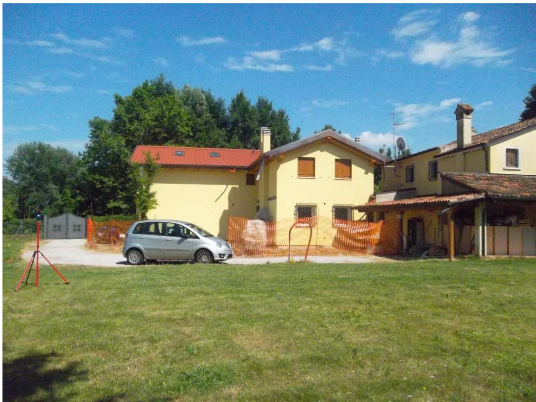
Figura 12: Particolare del prospetto ovest durante la scansione
