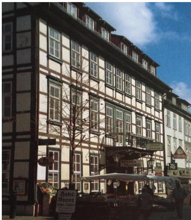
Fig. 16 – L' Hotel Sonne in Filmer W., Mayr W. (1997) „Die Harzreise: Auf Heinrich Heines Spuren“.
