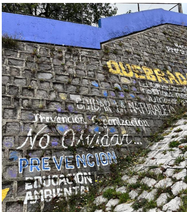
Muro en la zona cero del aluvión de 2022, La Comuna. Fuente: foto de la autora.
