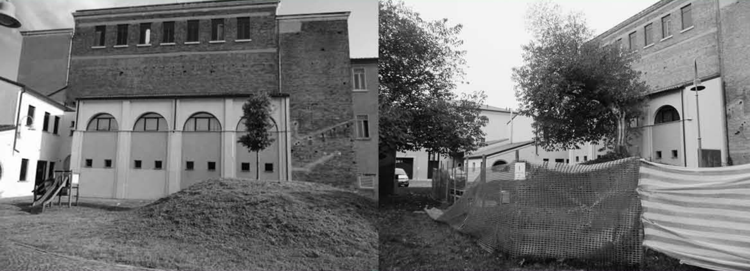
2 DESTINAZIONE D'USO: Vano impiantistico e sala polivalente
