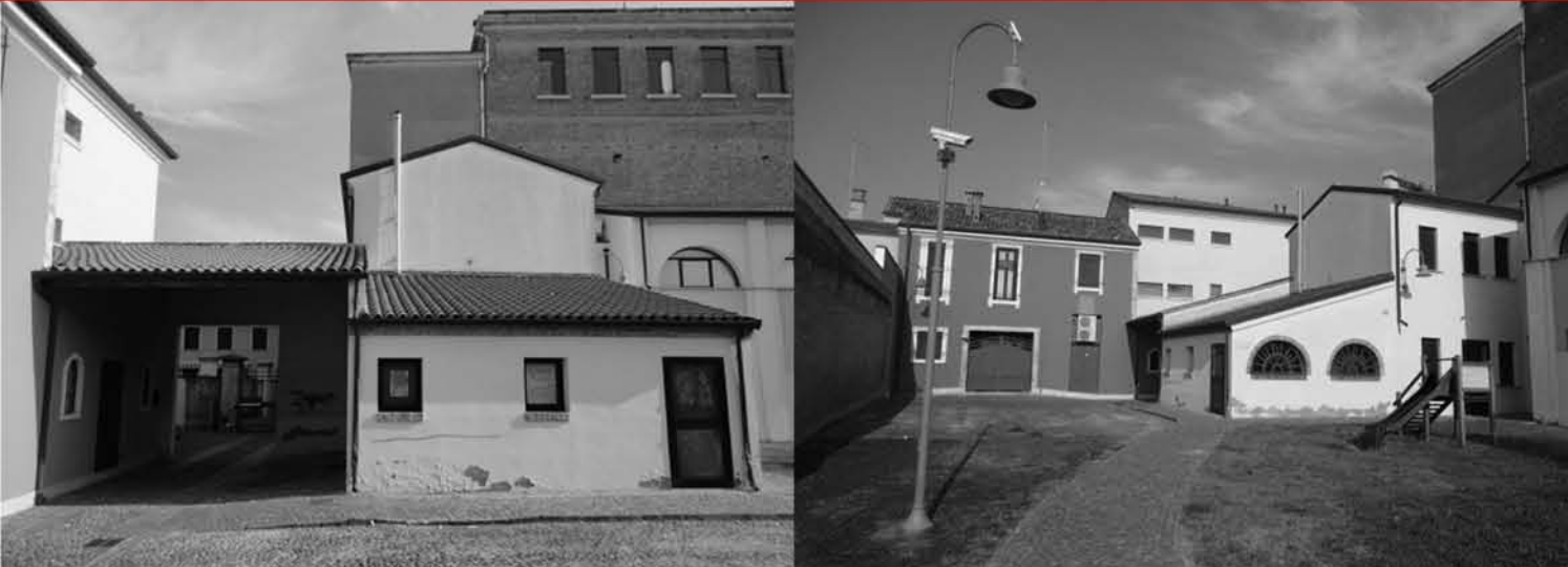
3 DESTINAZIONE D'USO: Edificio di raccordo tra Vicolo Prigioni e giardino Zen
