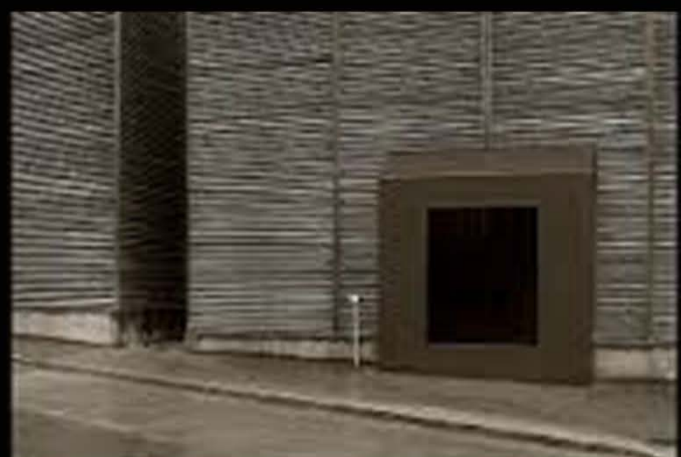
Struttura di protezione per rovine romane, Coira, Peter Zumthor, 1985 - 1986.
