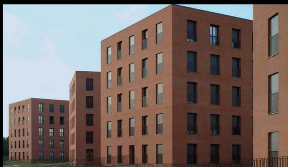
Residenze e Servizi del Campus Universitario di Parma, Parma, Carmassi Studio di Architettura, 1999 - 2007.
