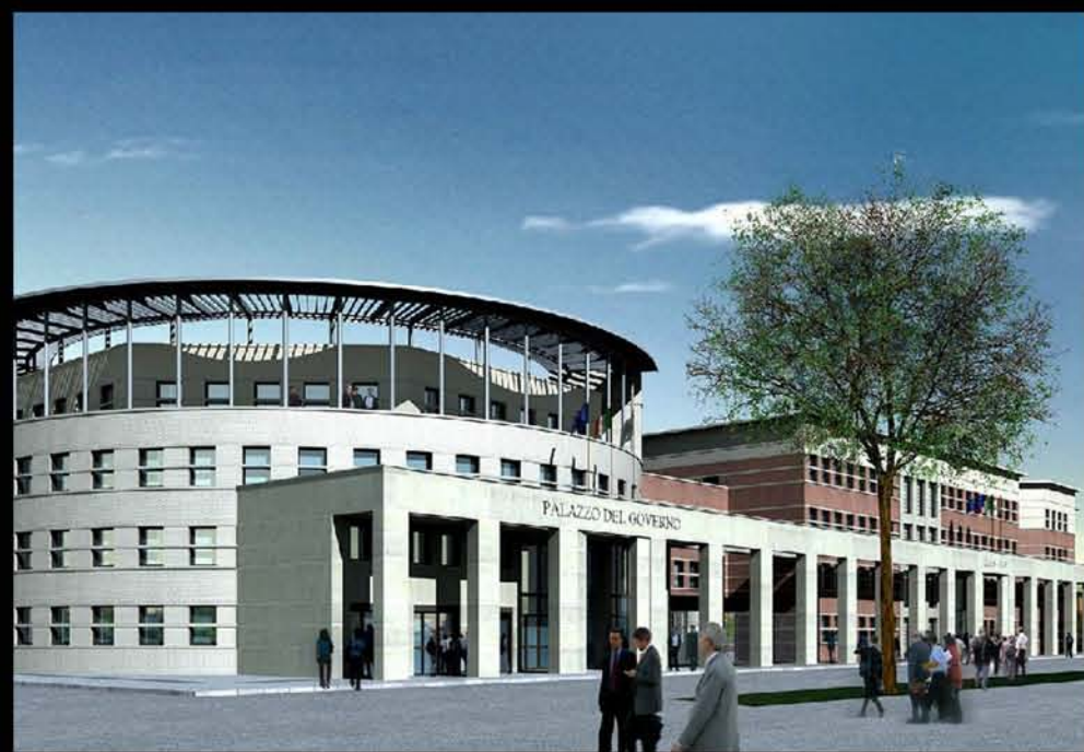
Nuova sede della prefettura e della questura e polizia stradale, area ex Breda, Pistoia, Natalini Architetti, 2001 ad oggi.
