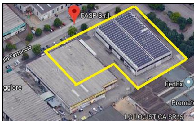
Figura 2.6- I due stabilimenti FASP
