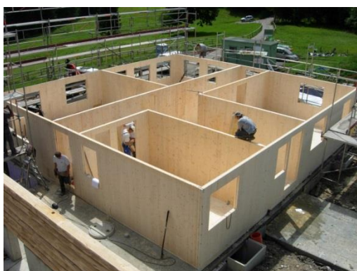
Figura 3.4 Fasi di cantiere di edifici prefabbricati con pannelli in X-Lam.
