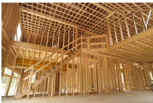
Figura 3.1 Esempi di applicazione della tecnica Platform Frame.
