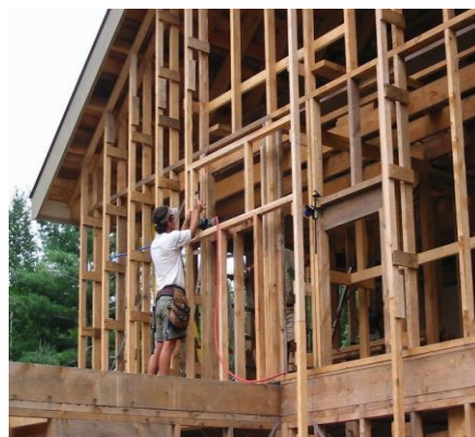
Figura 3.1 Esempi di applicazione della tecnica Platform Frame.
