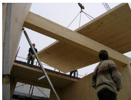
Figura 3.4 Fasi di cantiere di edifici prefabbricati con pannelli in X-Lam.
