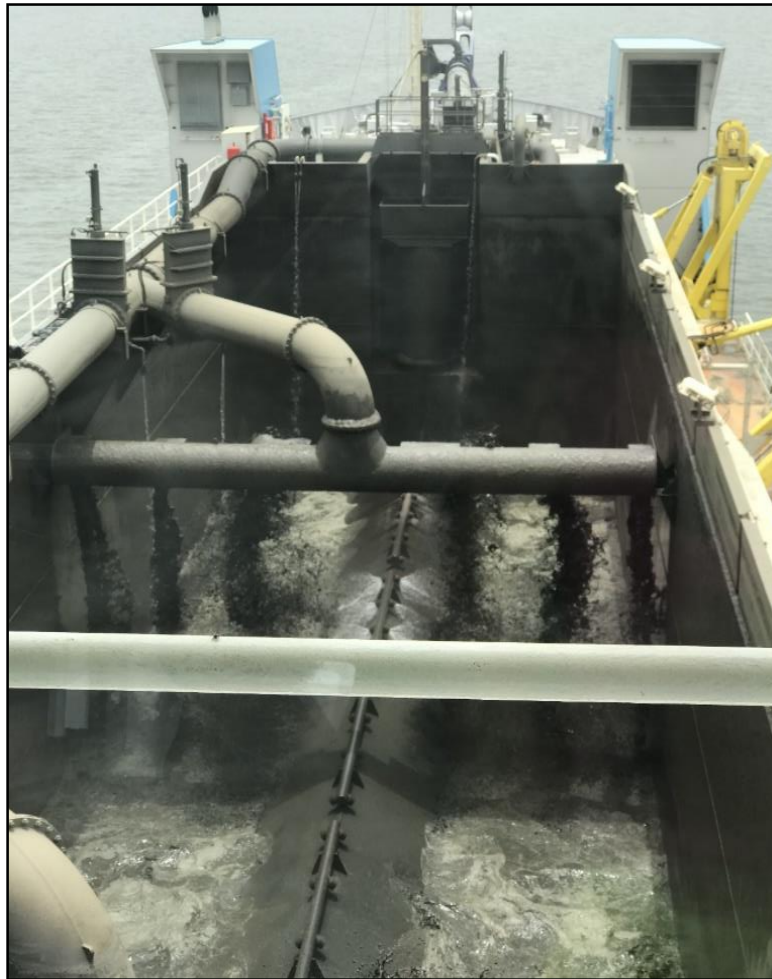
Figure 27 : Refoulement des sédiments dans le puits
