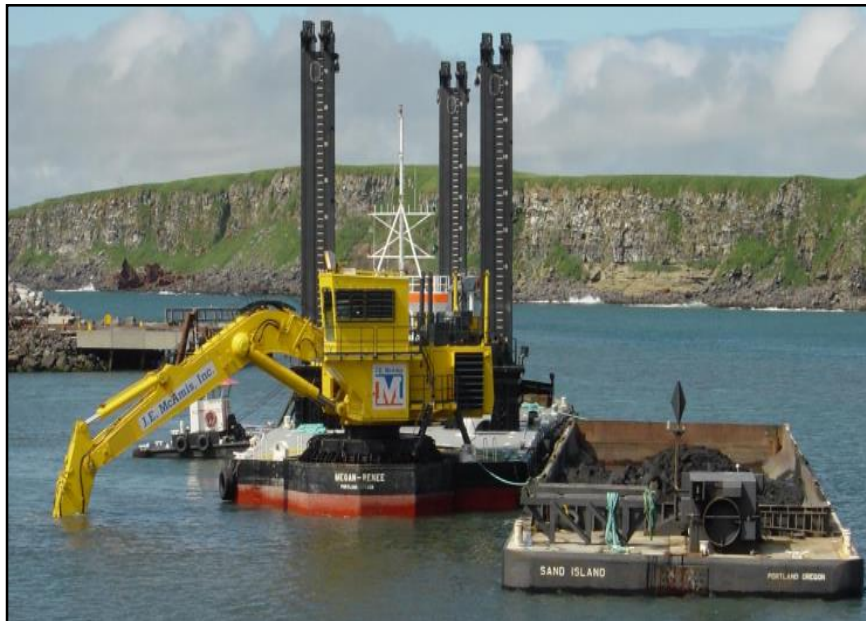
Figure 15 : Rejet par barges (SCE/CREOCEAN, 2019)
