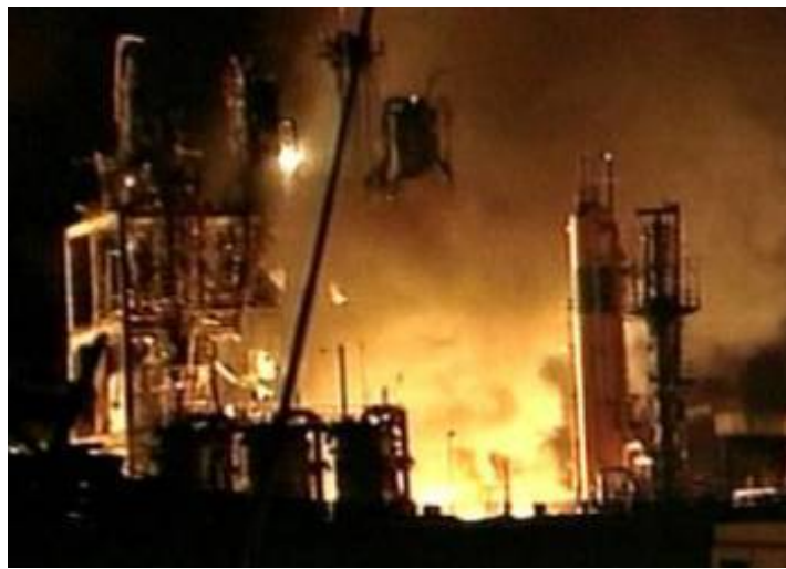
Figura 3.9 – Incendio nell'impianto di Skikda.
