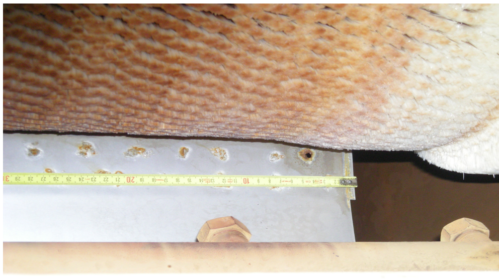
Foto3. Dettaglio delle saldatura tra colis successivi, Thyssenkrupp Torino
