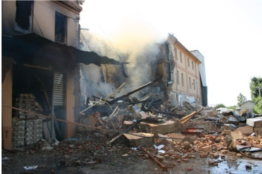
Foto 12. Danni lato NORD con crolli diffusi prevalentemente da collasso statico, Molino Cordero
