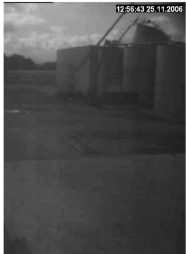
Foto 2. Sequenza di frame tratta dalle telecamere di video sorveglianza dove si vede la dinamica della prima esplosione, che ha interessato il Serbatoio 95, da Umbria Olii, Spoleto
