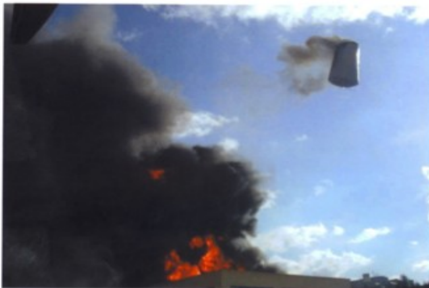
Foto 3. Proiezione Serbatoio 94 a seguito di esplosione immortalata dai VV.F. intenti a spegnere l'incendio seguito all'esplosione del Serbatoio 95
