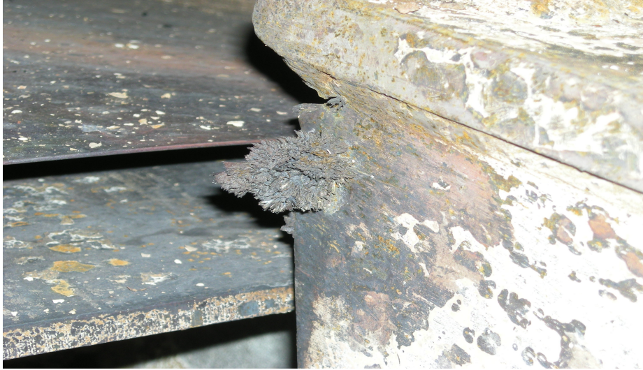
Foto 6. Segni su carpenteria da sfregamento, ThyssenKrupp Torino
