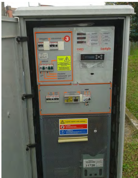
Figura 55 - Riduttore di potenza di via Antelao.
