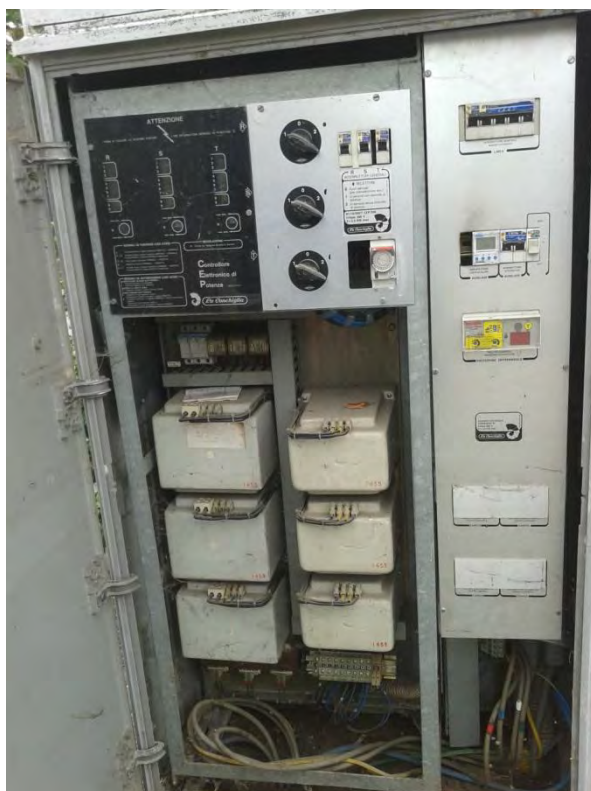
Figura 54 - Riduttore di potenza di via Roma.
