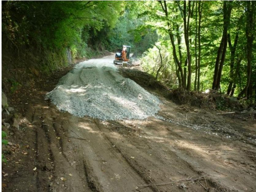
Figura 2.7 Esempio di stesura della massicciata.
