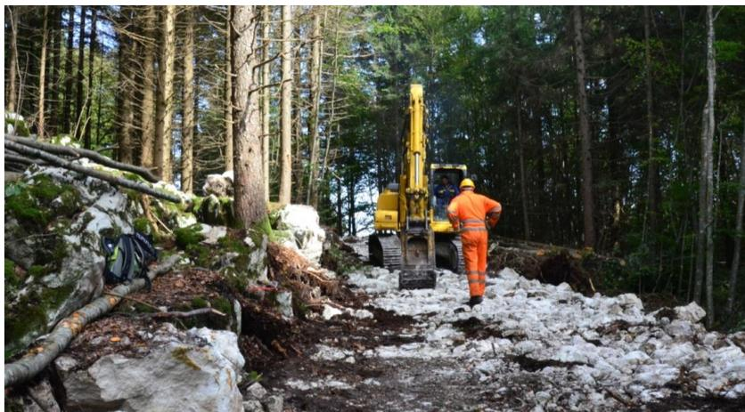
Figura 2.6 Esempio di apertura del tracciato per la realizzazione di una nuova strada.
