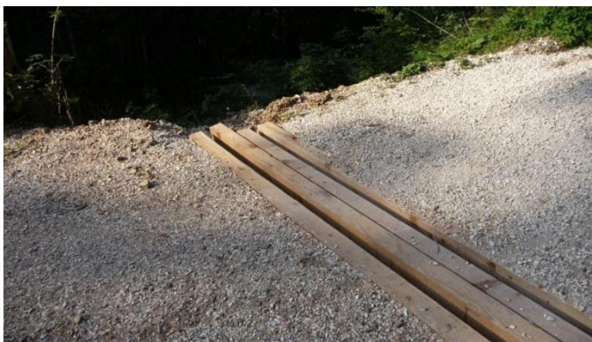
Figura 2.8 Esempio di canalette trasversali classiche in legno.
